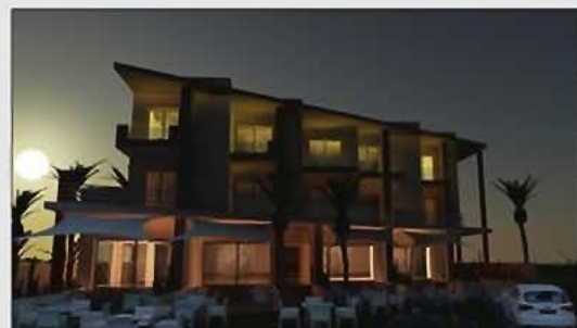
Immeuble à la Marsa de Style Moderne
