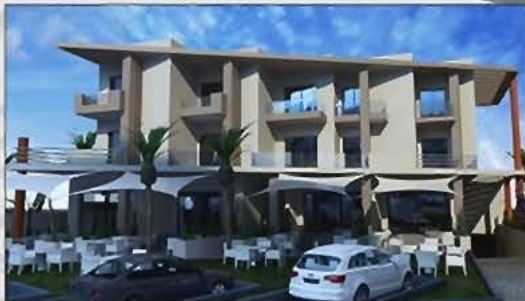
Immeuble à la Marsa de Style Moderne
